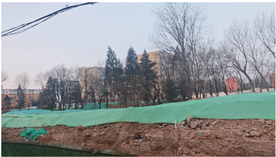
照片 2-4 建设用地内部现状
