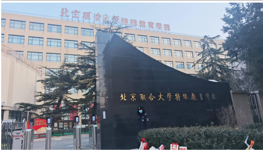
照片 2-6 建设用地北侧建筑
