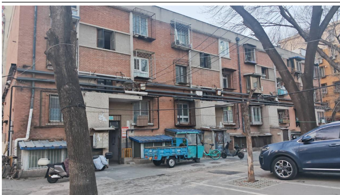
照片 2-2 建设用地南侧建筑
